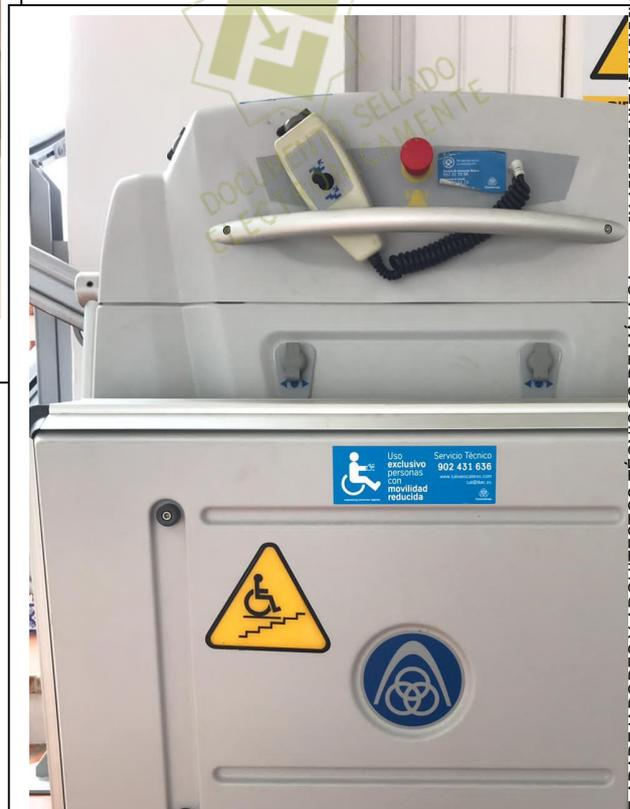
Ilustración 12: Fotografía facilitada por la propiedad. Plataforma equipada de señal de alarma..
